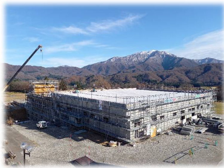
浄水処理施設建築工事
